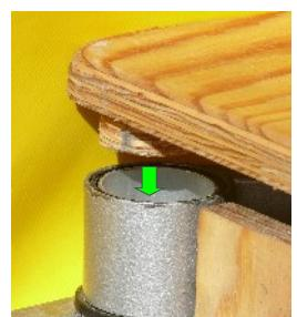
**10** Glisser une poubelle pré-remplie (15 cm de sciure sèche) par la trappe arrière et vérifier son bon positionnement par l'intérieur de la cabine.
