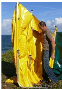
**2** Retourner la structure, écarter les pieds au maximum et mettre la barre à rideau par l'intérieur puis serrer les écrous papillon à la main.
